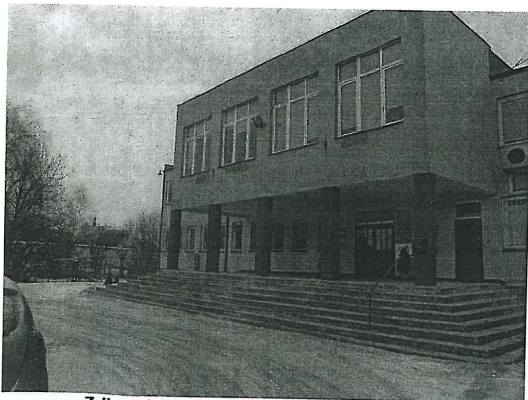
Zdj. nr 1- Widok ogólny przedmiotowego budynku.
