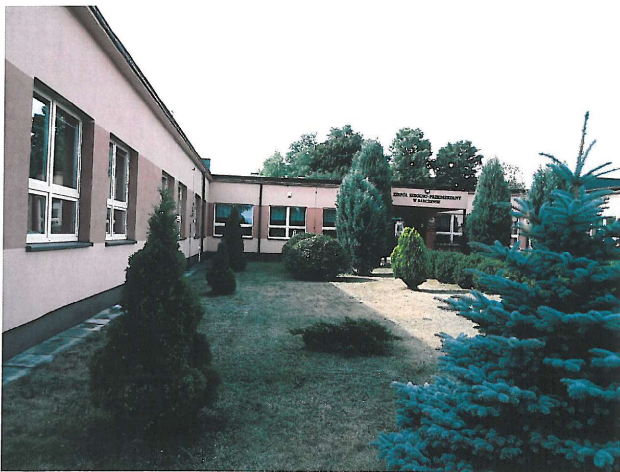
Zdj. nr 1- Widok od strony północnej.
