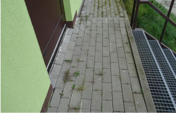
widoczne zapadnięcia chodnika z kostki betonowej
