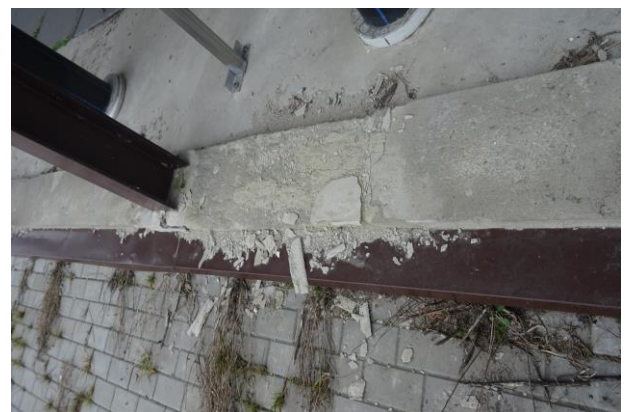
uszkodzenia obróbki blacharskiej oraz krawędzi żelbetu
