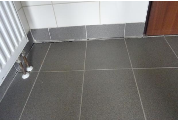
zapadnięte i odspojone fragmenty posadzki z płytek gresowych
