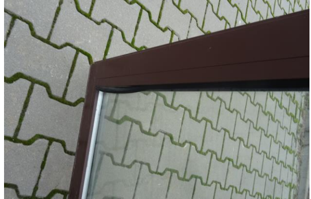
widoczne uszkodzenia sufitów na skutek zawilgocenia oraz wypadające uszczelki w konstrukcji aluminiowej
