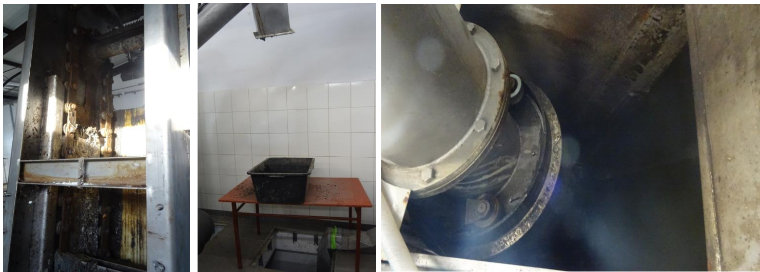
Zły stan łańcuchów, nieprawidłowy rękaw zrzutowy, wielokrotnie naprawiany bęben sitopiaskownika
