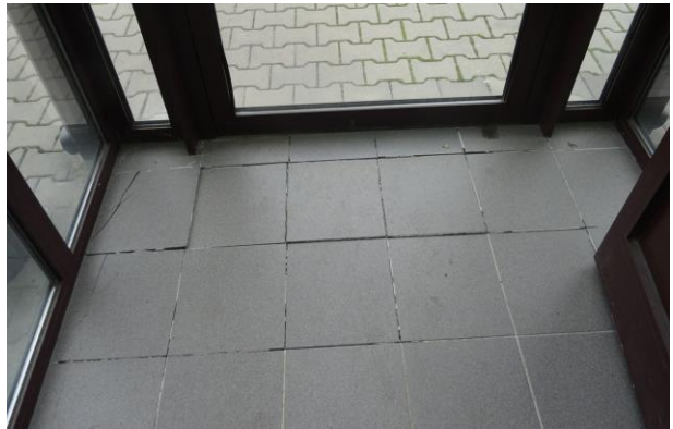
zapadnięte i odspojone fragmenty posadzki z płytek gresowych
