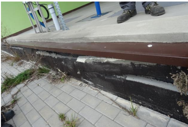
zdjęcia obrazują odspojone warstwy ocieplenia ścian SBR
