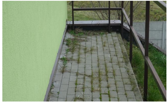
widoczne zapadnięcia chodnika z kostki betonowej
