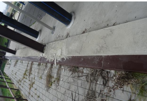
uszkodzenia obróbki blacharskiej oraz krawędzi żelbetu
