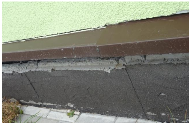
zdjęcia obrazują odspojone warstwy ocieplenia ścian SBR
